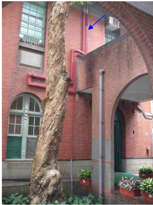
案例二：第一行政大樓北棟（古蹟）
